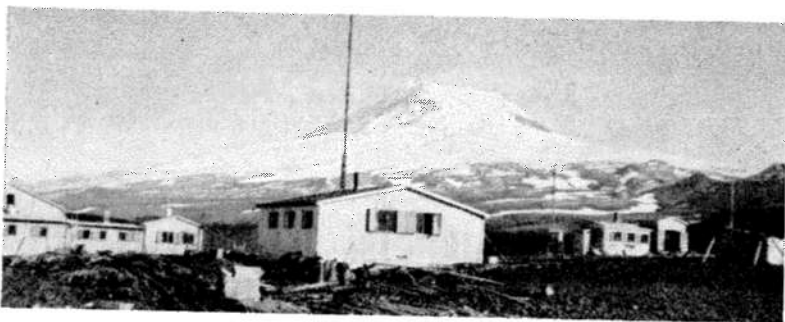
Den nye met. og radiostasjon på Jan Mayen under oppførelse 1949.
