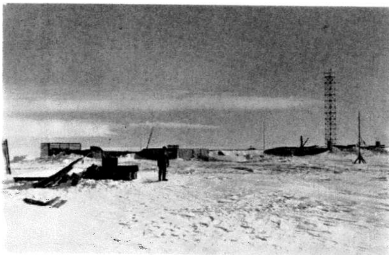
«Norway Station» under bygging.
