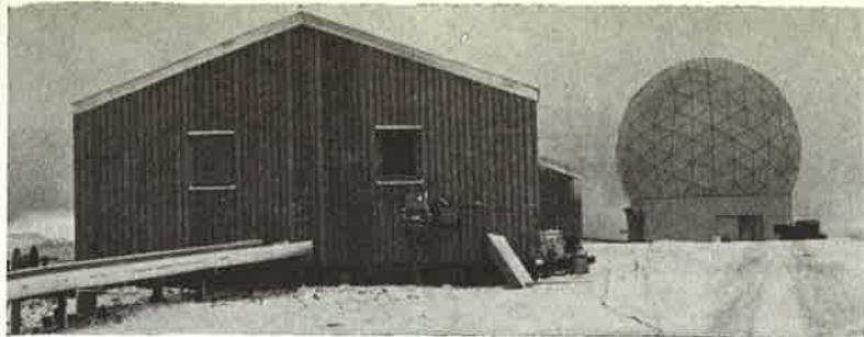
Det ferdige stasjonshuset med ledningskasse for kabler fra mot-takerradomen. Den minste av de to radomene i bakgrunnen.
