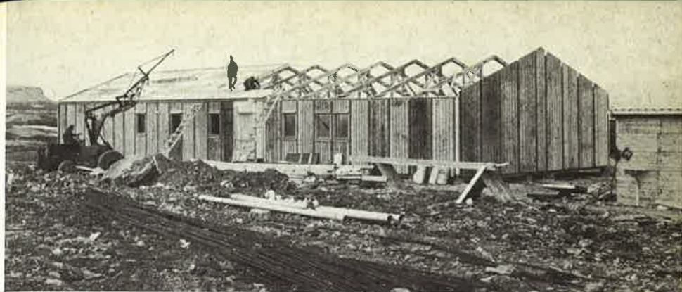
Det 360 m 2 store telemetristasjonshuset under oppførelse.
