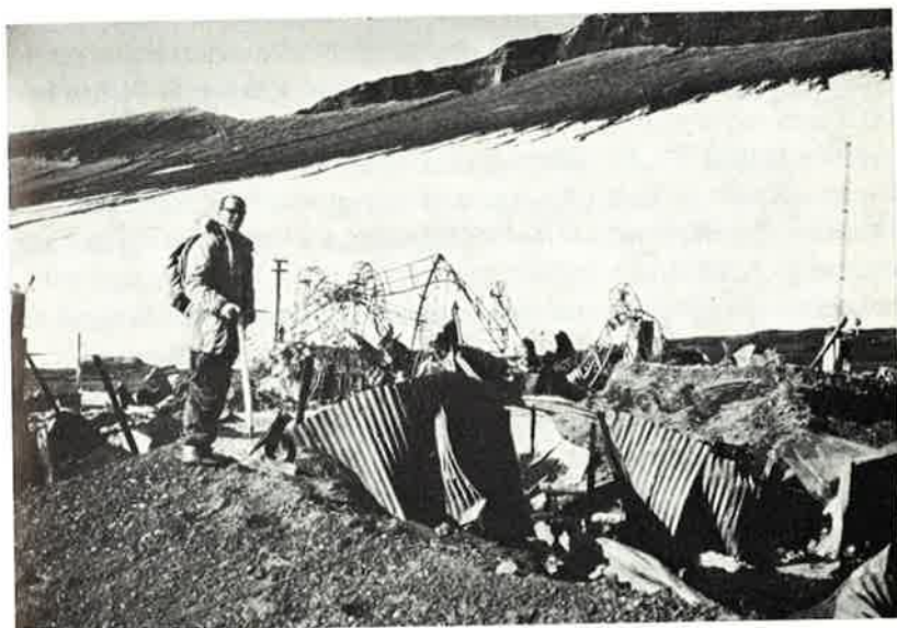
Den chilenske stasjonen etter utbruddet i 1969. Bare forvridde jernbiter og noen sementblokker gjenstår av bygningene som engang huset over 30 mann — resten er oppbrent.
