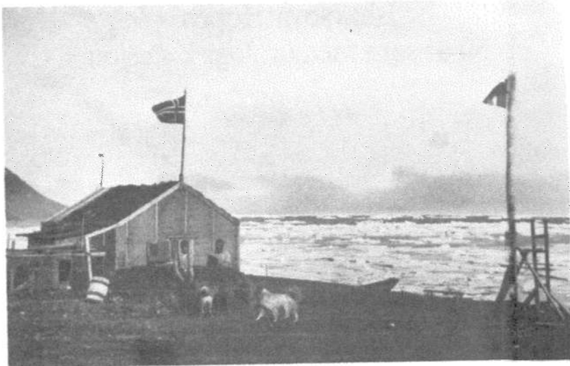
Storstadhuset. Det ble bygget av fangstmennene Sigurd Storstad, Børre og Birger Trøhaug som overvintret på Hopen sesongen 1934-35.
