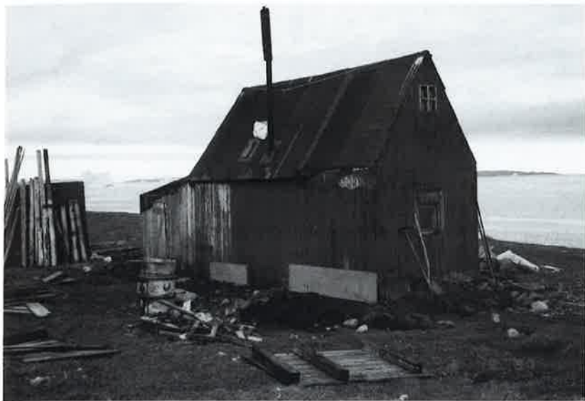
Kap Humboldt-stasjonens bakside 2. august 1997. Unødvendig bislag og veggpapp er fjernet.
