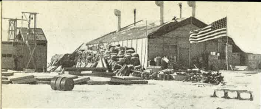
Byrds ekspedisjon: Overvintringshusene under bygging.
