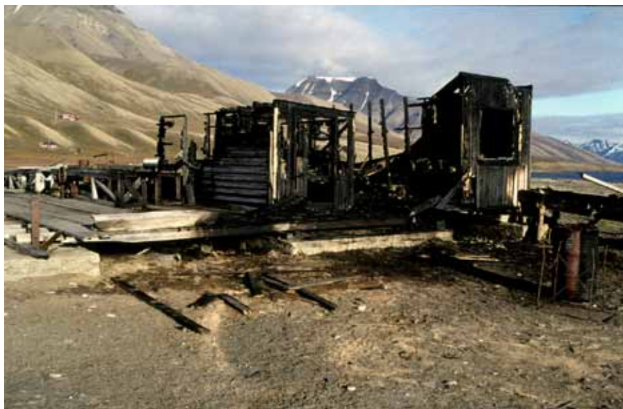
Saghusbrakka brant 24. august 2000 som følge av fyring i ovnen uten tilsyn. (Foto: Kolbein Dahle/Syssele mannen på Svalbard).
