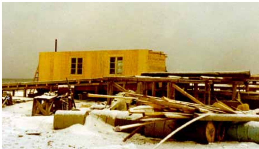
Saghusbrakka ble bygget høsten 1972 av materialer skåret på stedet. (Foto: Per Johnson).
