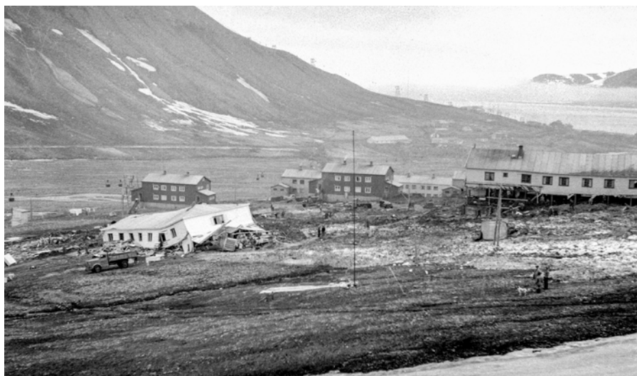
Fig. 8. Den 11. juli 1953 traff et sørpeskred fra Vannledningsdalen flere boliger, Funksjonærmessa og sykehuset. (Fotograf Leif Archie Grøndal © Grøndal Foto).
