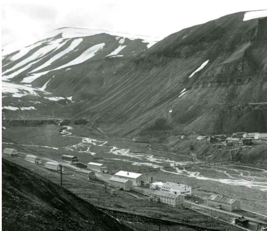
Fig. 4. Nybyen i forgrunnen, Sverdrupbyen på steinbreen bak til høyre, utslaget til Gruve 1b i fjellsiden over dette, Løwøbrua og Longyearbreen i bakgrunnen til venstre. Bildet tatt i 1964. (Foto: L. Langnes, Svalbard Museum).
