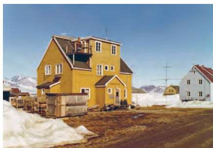
Gult Hus med plattformer på taket for optisk utsyr.
