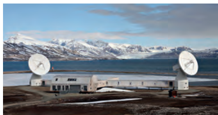
Ferdig stasjon i 2018. (Foto: B.O. Holmberg).
