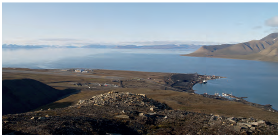
Figur 6. Skjæringa ved Trøndergruva sett ovenfra og mot nordvest. I bakgrunnen Adventfjorden, august 2009. (Foto: P.J. Brugmans).
