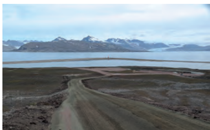
Plassen ved Brandallaguna er klar for bygging høsten 2014. (Foto. T. Nørbech).
